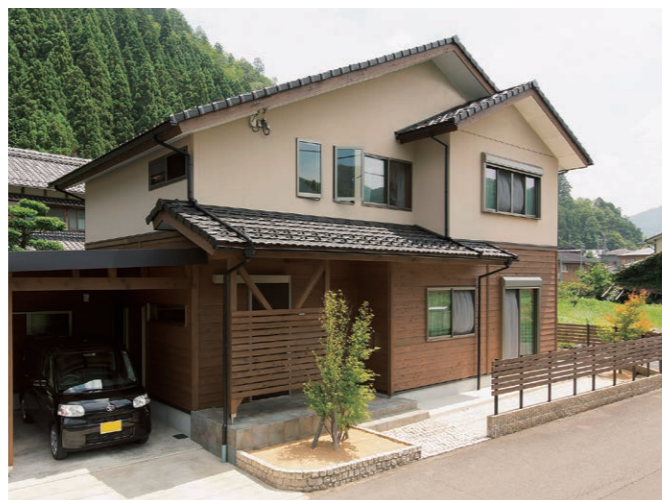
緑の山にとけ込む、大屋根の外観。スギの外壁やフェンスは、施主参加で塗装を。愛着が生まれる家づくりです。
